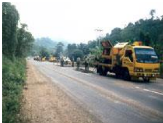
Gbr 2. Pembangunan jalan untuk memperlancar arus lalu lintas barang, jasa, dan manusia
