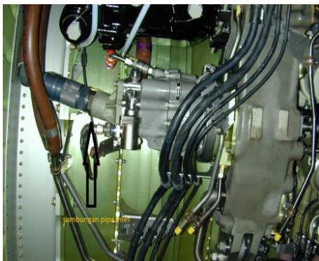
Gambar 2 Kebocoran pada pipa Inlet
