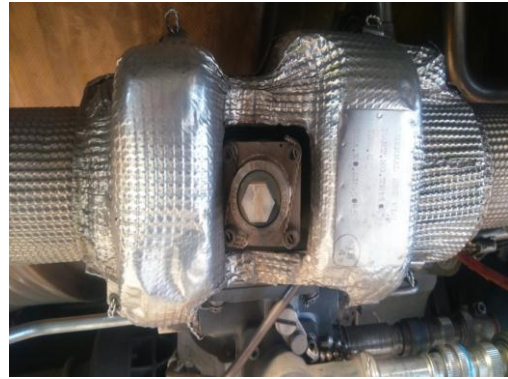
Gambar 12. Engine anti-ice valve yang telah terpasang
