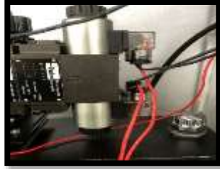
Gambar 5 Proses penghubungan cabl pada solenoid control valve
