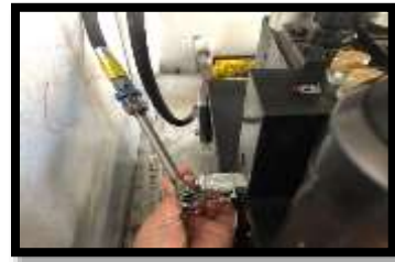
Gambar 6 Penghubungan flexiblehose pada motor pump
