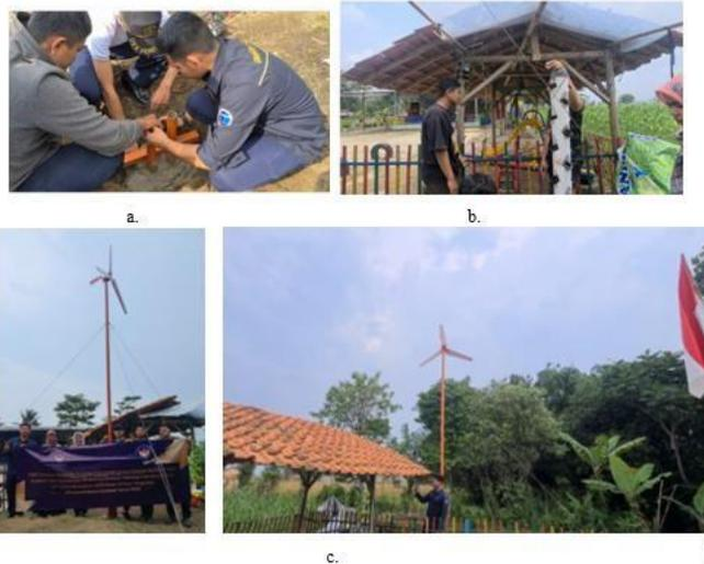
Gambar 10. Proses pemasangan kincir angin dan sistem hidroponik yang diterapkan kepada masyarakat: a. memasang dudukan tiang kincir angin, b. Intalasi sistem listrik kincir angin dan sistem hidroponik, c. kincir angin dan sistem hidroponik sudah terpasang
